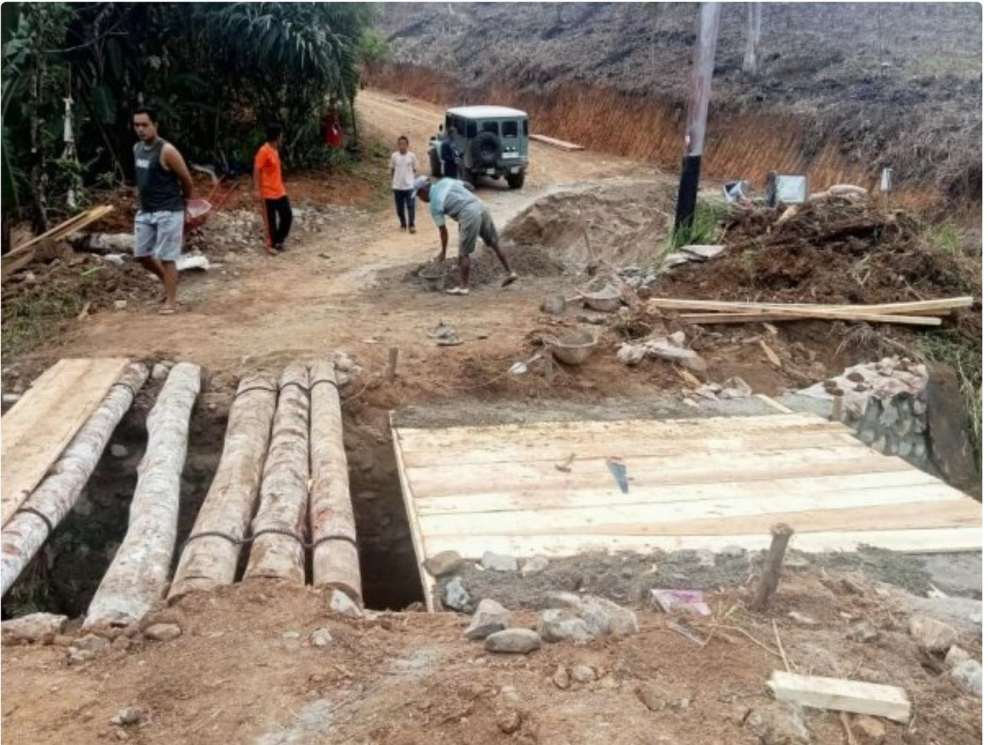
Pasaman, - Satgas TMMMD ke-119 Kodim 0305/Pasaman membangun jembatan darurat untuk memperlancar pengecoran lantai plat daiker dan pembangunan badan jalan, Senin (18/03/2024).
